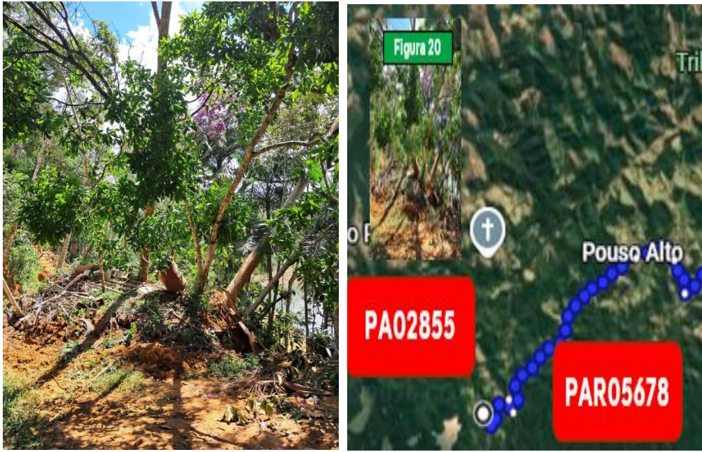
Figuras 20 (Foto tirada pela equipe Neoenergia Elektro durante atendimento da Ocorrência )
