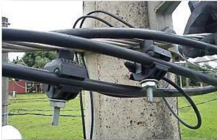
Figura 02 – Detalhe da ligação dos cabos de 1,5 mm 2 com conectores homologados
