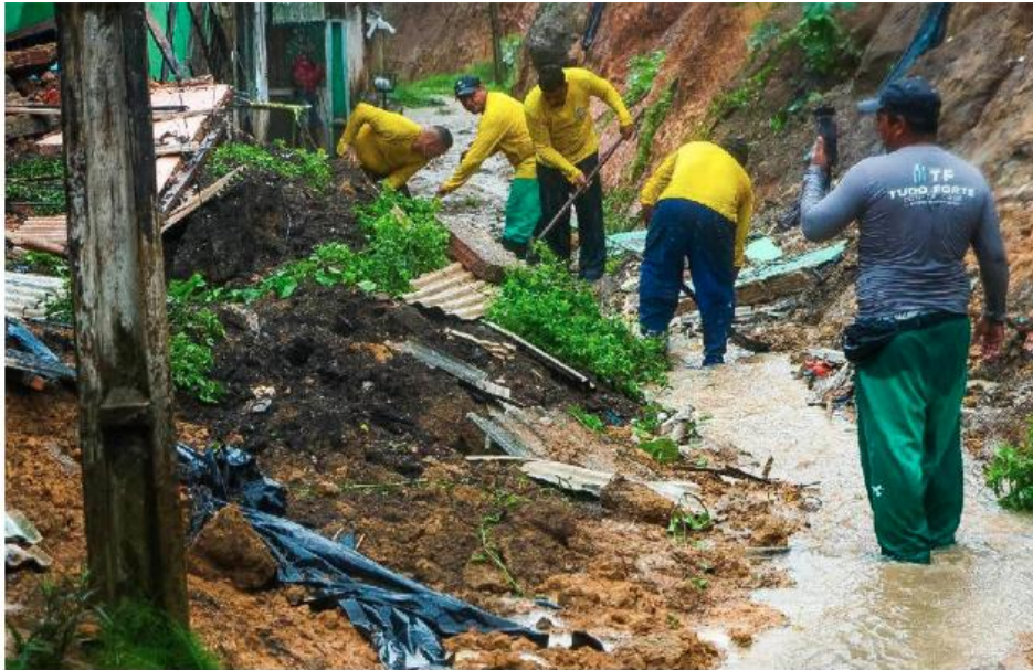
Deslizamento de barreira atinge casa no bairro da Mirueira, em Paulista, no Grande Recife - Divulgação/Prefeitura de Paulista
