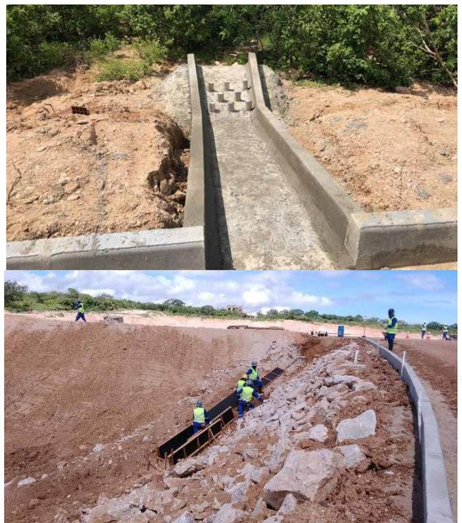
Sistema de drenagem instalado em Parques eólicos
