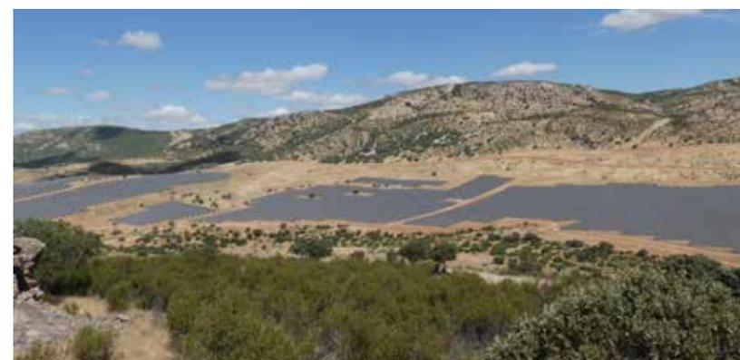
O projeto é planejado para obter o máximo de produtividade para um mínimo de ocupação do terreno, para o qual foram instalados 249.144 painéis bifaciais de 400 Wp, com maior eficiência e menor ocupação de espaço que os módulos convencionais. A potência total instalada é, portanto, de 99.658 MWp, a que se junta uma bateria de 5 MW que permite armazenar e regular a descarga de energia à rede, o que resulta numa melhor utilização do recurso.
