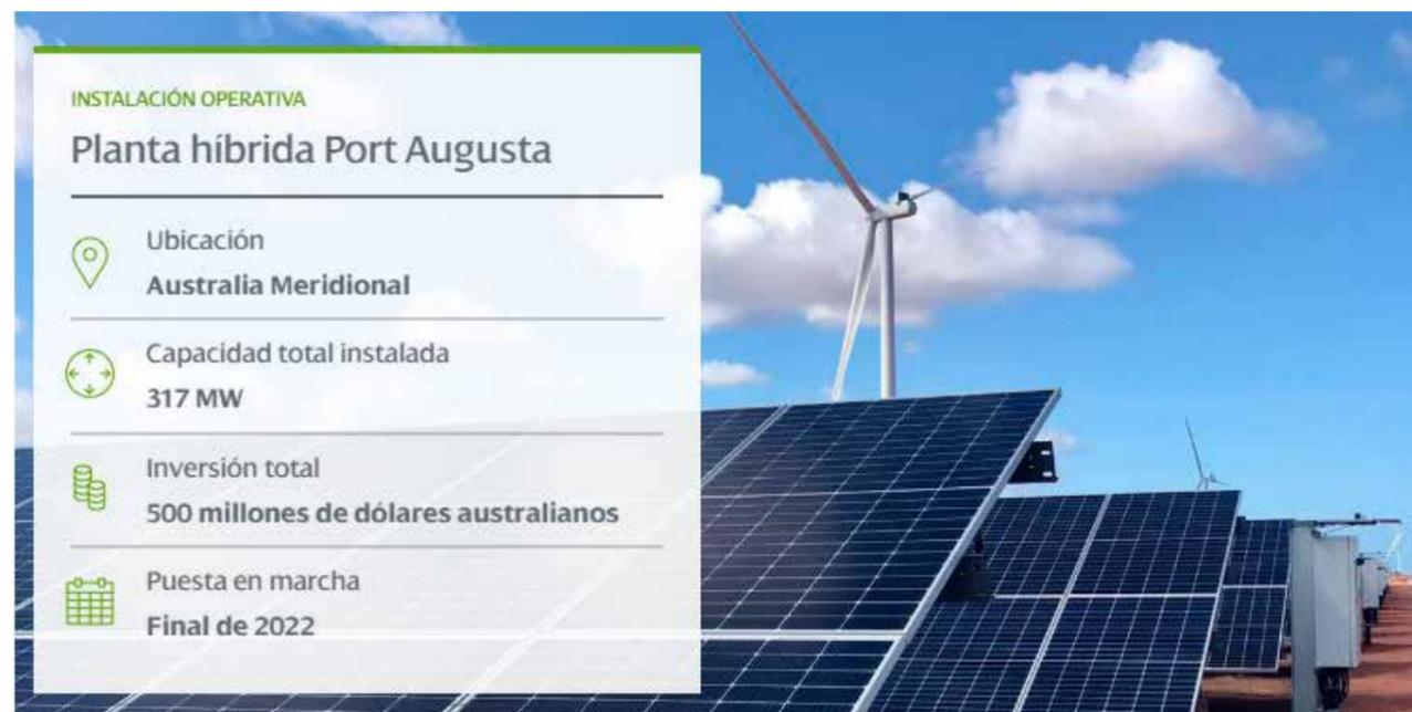
O projeto de Port Augusta, localizado no estado da Austrália do Sul, é até hoje a primeira usina eólica-solar híbrida do Grupo Iberdrola no mundo, combinando 210 MW de energia eólica com 107 MW de energia fotovoltaica, com uma capacidade total de 317 MW. Representou um investimento de 500 milhões de dólares australianos (mais de 323 milhões de euros).
