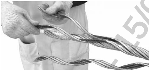
Terminação da Emenda no cabo
