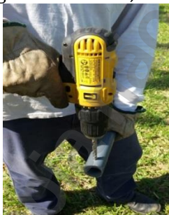
Figura 05 - Furação do tubo de ajuste
