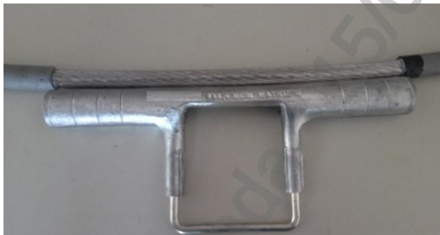
Compressão do conector ao condutor
