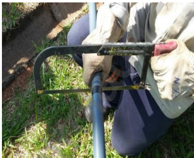
Figura 04 - Corte do tubo de ajuste
