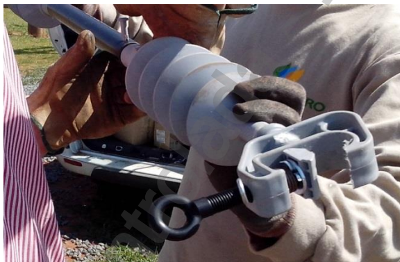
Figura 01 – Instalação do isolador com garra com pino travante
