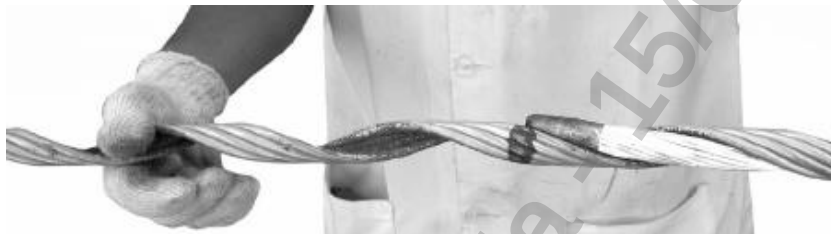
Aplicar metade da emenda no cabo
