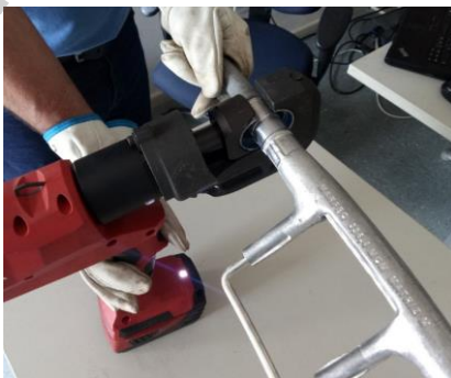
Compressão do conector ao condutor
