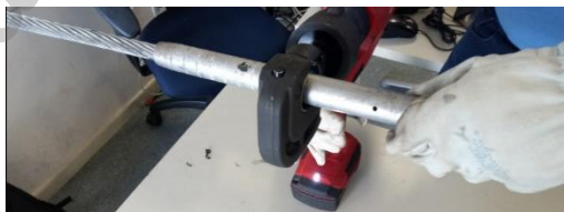
Compressão do conector ao condutor
