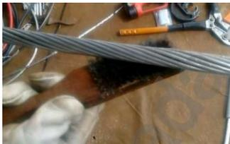
2º Passo – Aplicar composto antióxido em toda extensão do condutor onde será aplicada a conexão;
