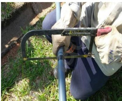
Figura 04 – Corte do tubo de ajuste
