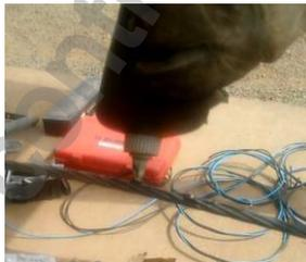
3º Passo – Escovar o condutor novamente espalhando o composto e friccionando o composto no condutor para evitar a oxidação;
