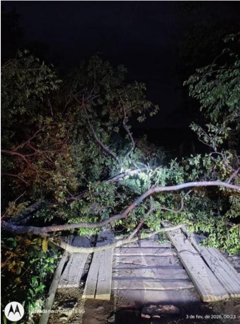
Figura 19 - Registro feito por colaborador no dia 02 de fevereiro de 2026 no município de Cocos.
