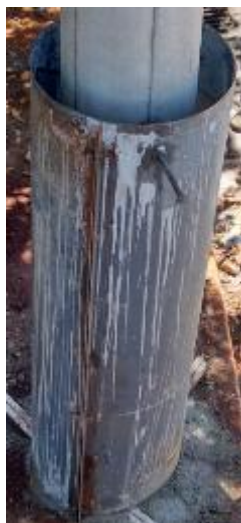
Fotos Ilustrativas – Forma para recuperação de poste
